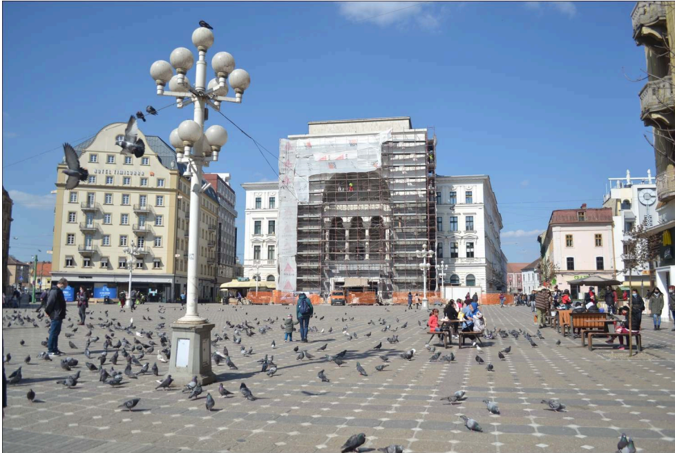
Illustration 13 - Façade de l'Opéra national de Timișoara en cours de restauration sur la place de la Victoire
