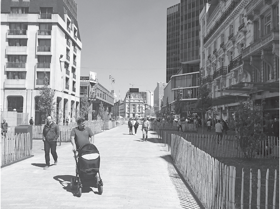
Figure 2. Premier tronçon aménagé du boulevard Anspach
