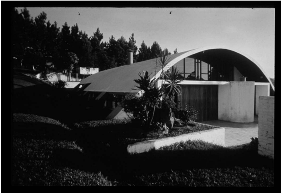
Figure 7 : Maison Bernardo Issler – vue extérieure (Sérgio Ferro architecte, 1961)
